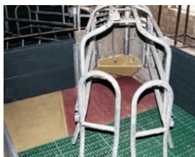
STALLIT Estrich-Original in einer teilperforierten Abferkelbucht mit Polymerbeton-Heizplatte
